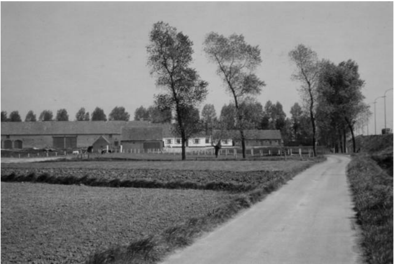
De langsgevelhoeve op een foto van kort na 1977
